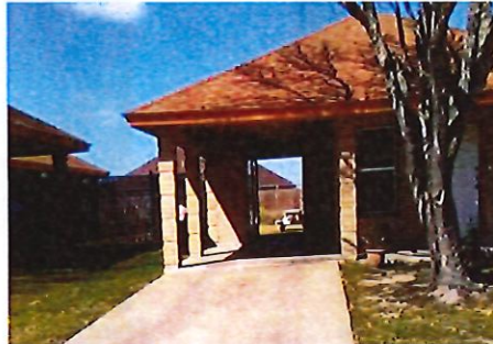
Patio Delantero / entrada de auto Aceptable
